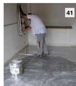
Direkt im Anschluss, Aufbringen der Deckbeschichtung StoPox BB OS
