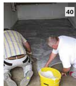
Abspachteln einer EH 200 Fläche mit sehr vielen Poren mit StoPox BB OS
