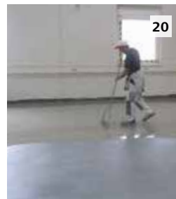
20 Abstacheln von StoCrete EH 200
