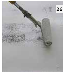
StoPox WL 100 wird von der Rolle wieder aufgenommen
