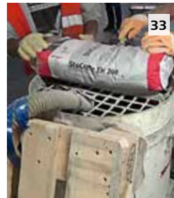
StoCrete EH 200 Komponente A (Pulver) hinzugeben
