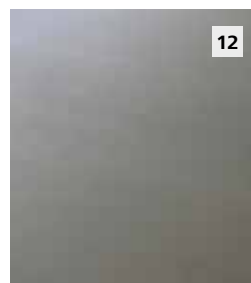
12 Rauer Untergrund mit Ausbruchstellen und Rissen nach dem Beschichten mit StoCrete EH 200
