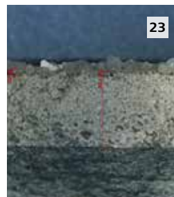
Eindringtiefe von Sand nach 30 Min. Quarzsand liegt lediglich an der Oberfläche. Keine ausreichende Einbindung gegeben.
