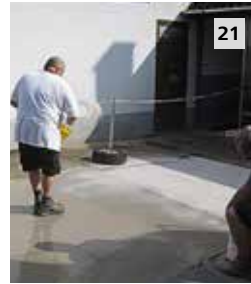
Abstreuen von StoCrete EH 200 mit Quarzsand
