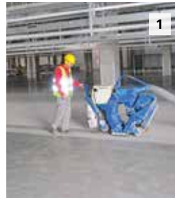
Untergrundvorbehandlung mittels Kugelstrahlen
