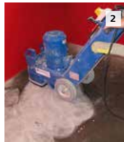
Vorbehandlung durch Schleifen
