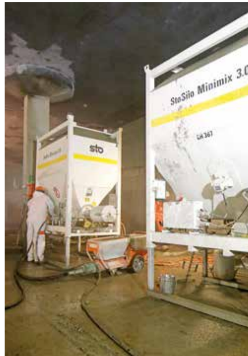
Gemeinsames Gesamtkonzept mit StoSilo Minimix 3.0 – angepasst an die geringe Durchgangshöhe im Tunnel
