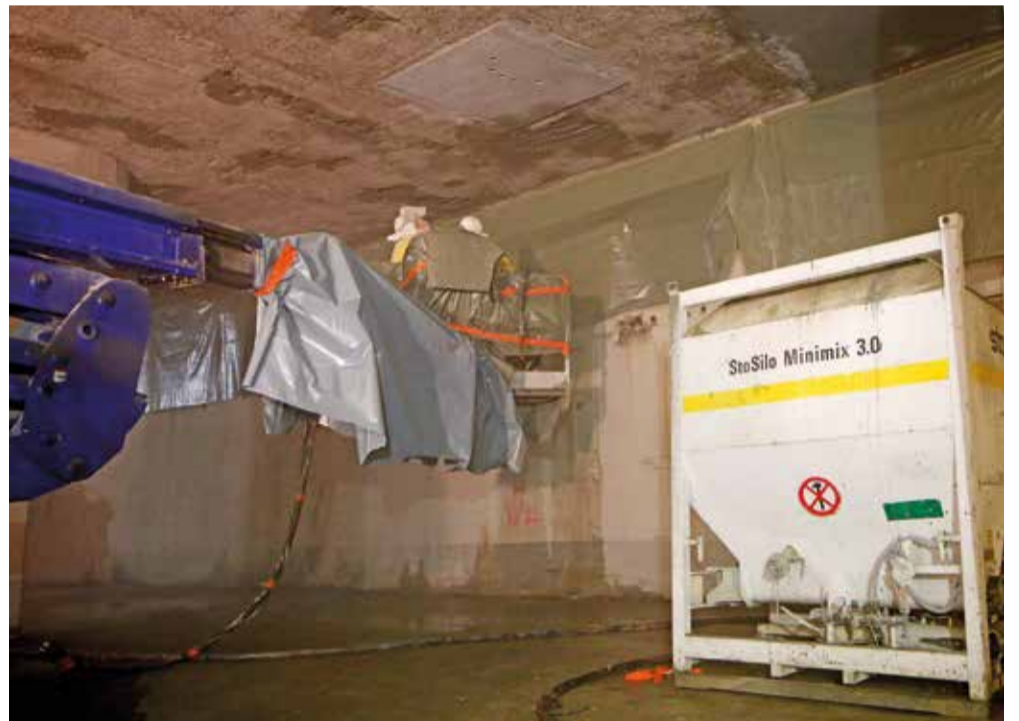
Schnelle und unkomplizierte Befüllung mittels Kran direkt vom Sto-LKW
