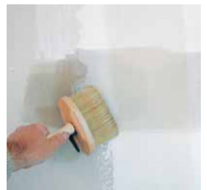
Grundieren mit StoPrim Plex
