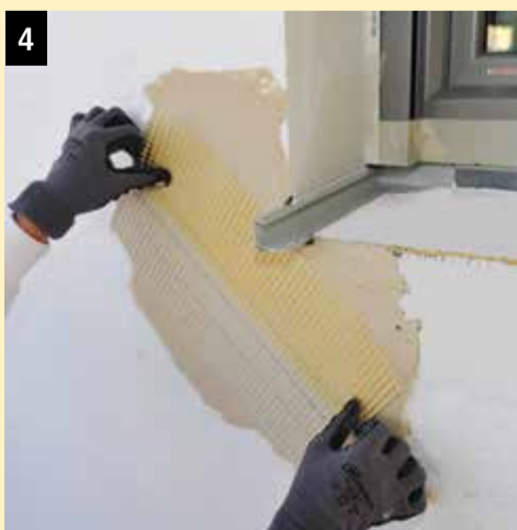
Sto-Solpad einkleben; Kantenschutzprofile und Diagonalarmierungen einspachteln.
