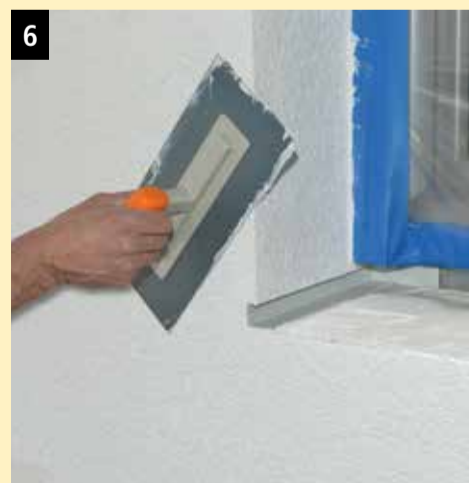
Fassade verputzen und streichen.
