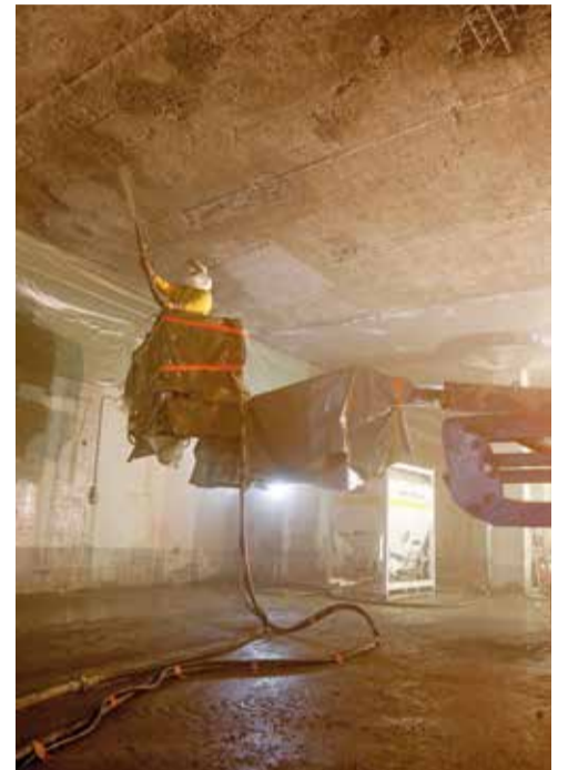
Gemeinsames Gesamtkonzept mit StoSilo Minimix 3.0 – angepasst an die geringe Durchgangshöhe im Tunnel
