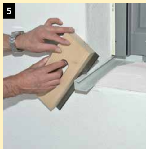
Nach Trocknen der Kantenschutz-Armierung überstehendes Solpad absägen; Flächenarmierung aufbringen.
