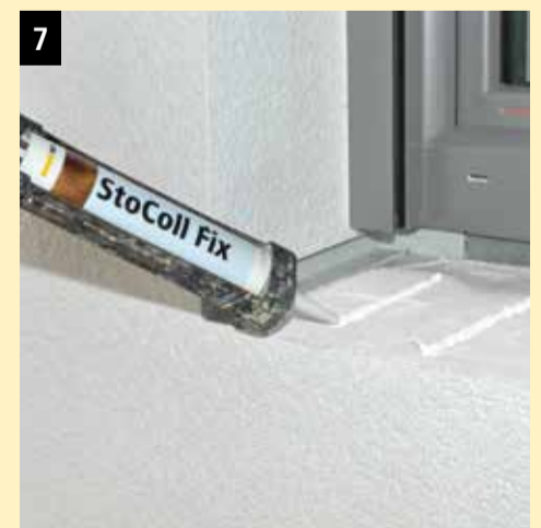
Fensterbank mit StoColl Fix einkleben und verschrauben.
