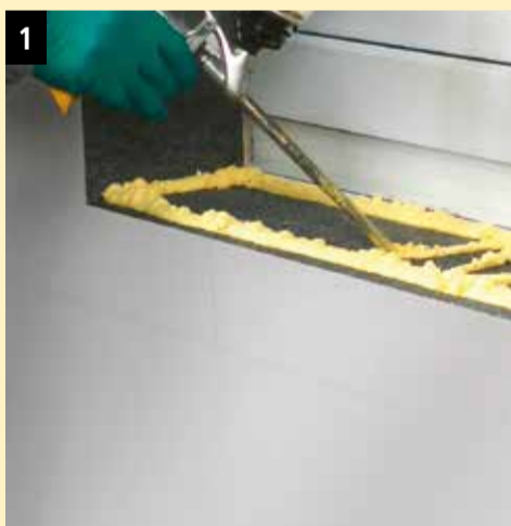
StoElement Pronto K zuschneiden und einkleben.
