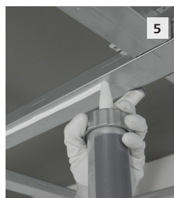
Figura 8: Ugello con l'intaglio a V
