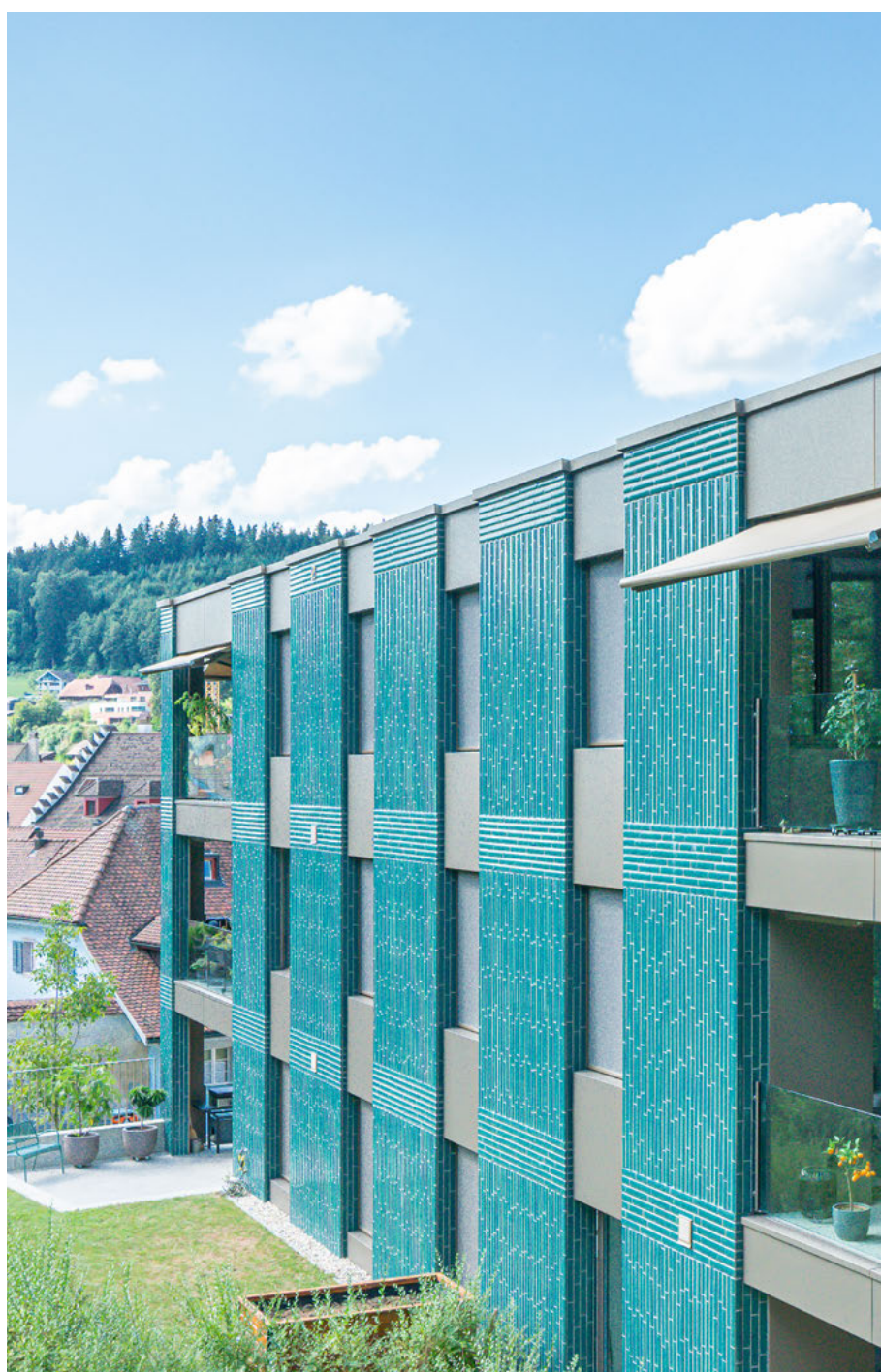
Casa plurifamiliare Mohrenplatz, Willisau, CH
