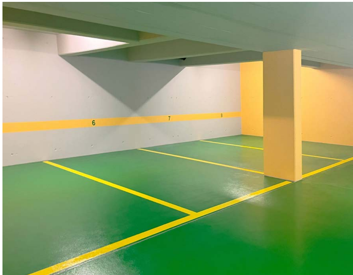
Foto a sinistra: Garage sotterraneo Sigirino, CH Competenze StoCretec: StoFloor Traffic Elastic 590 EP, StoSeal 505
