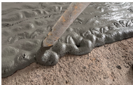
StoCrete TG 302 può essere pompato ed è quindi particolarmente adatto per grandi superfici industriali.
