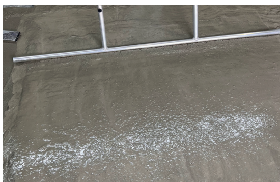
StoCrete TG 302 può essere livellato e compattato con una barra livellatrice o un massetto vibrante stando in piedi, proteggendo ginocchia e schiena.
