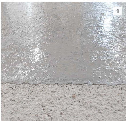
1 Come malta per mano di ancoraggio direttamente su fondo in calcestruzzo
