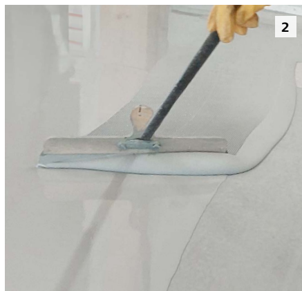
2 Come rivestimento autolivellante liscio per pavimentazioni industriali
