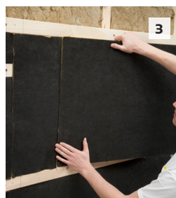
Glaswolle- bzw. Steinwolleplatte VHF vlieskaschiert zwischen die Grundlattung legen und leicht andrücken. Eine Sicherung der Dämmplatten gegen Abrutschen und Herauskippen erfolgt durch die vertikale Traglattung. Eine evtl. vorhandene Wärmedämmung ist unabhängig von der Unterkonstruktion direkt am Bauwerk zu befestigen. Der Dämmstoff muss lückenlos verlegt werden. Es ist darauf zu achten, dass er fest an der Gebäudewand anliegt.
