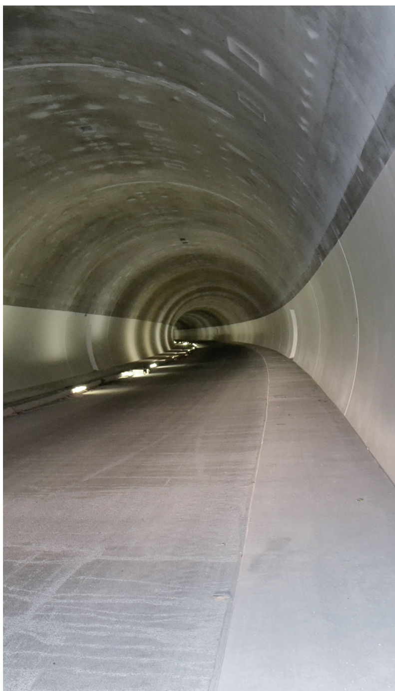
Tunnel Hirschhagen, Helsa DE Committente Hessen Mobil-Strassen und Verkehrsmanagement, Kassel DE Lavorazione : Baunatal DE Competenze Sto: risanamento del calcestruzzo e protezione delle superfici con StoPox TU 100 Foto: StoCretec GmbH, DE
