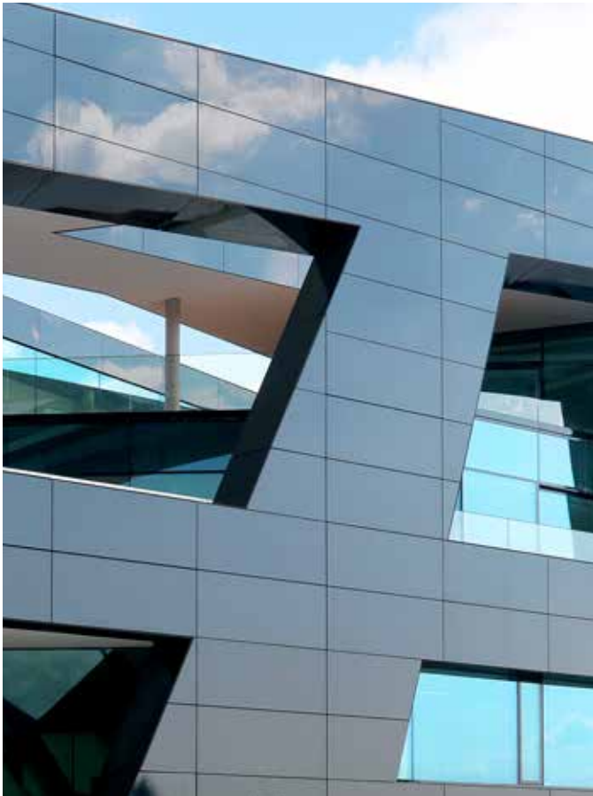
Transition des éléments en verre noirs à fixation invisible avec joints apparents aux embrasures
