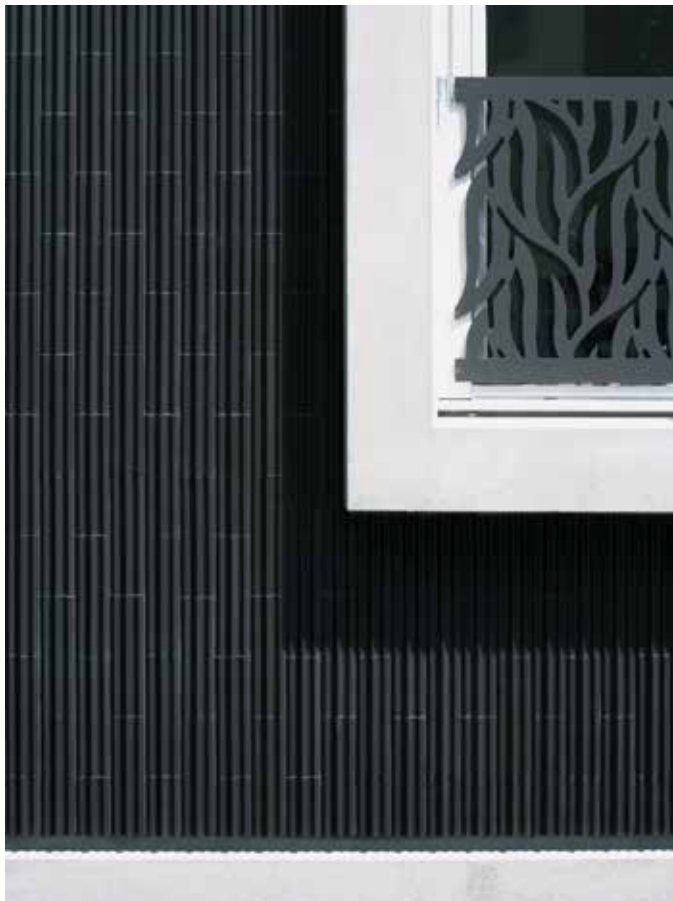
Transition des matériaux de la base et la fenêtre à la façade en céramique
