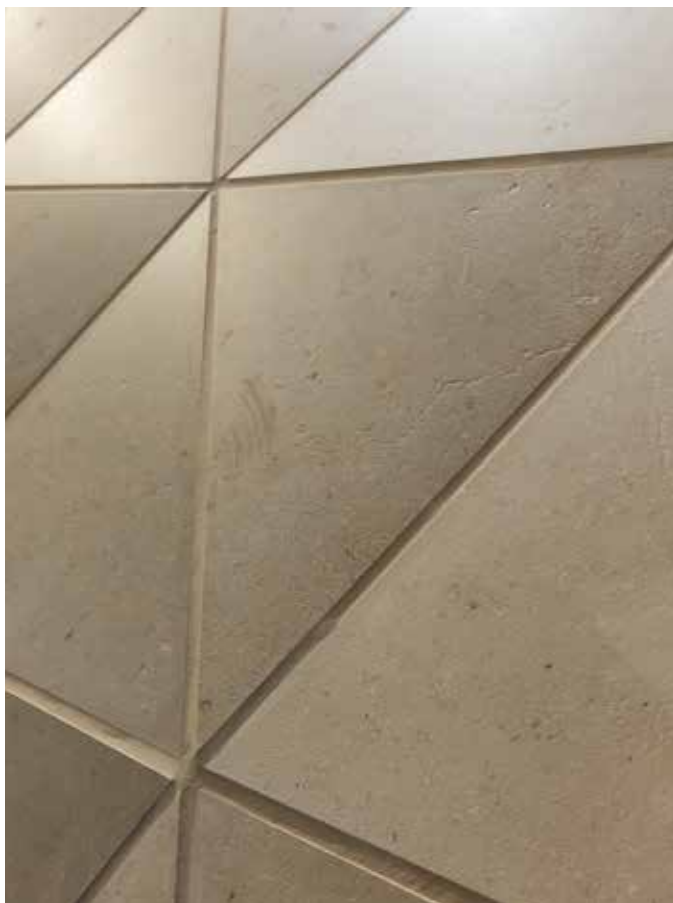
Détail des carreaux en pierre naturelle comme revêtement parfaitement découpé en forme libre, mortier de jointoiment teinté comme élément de décoration supplémentaire
