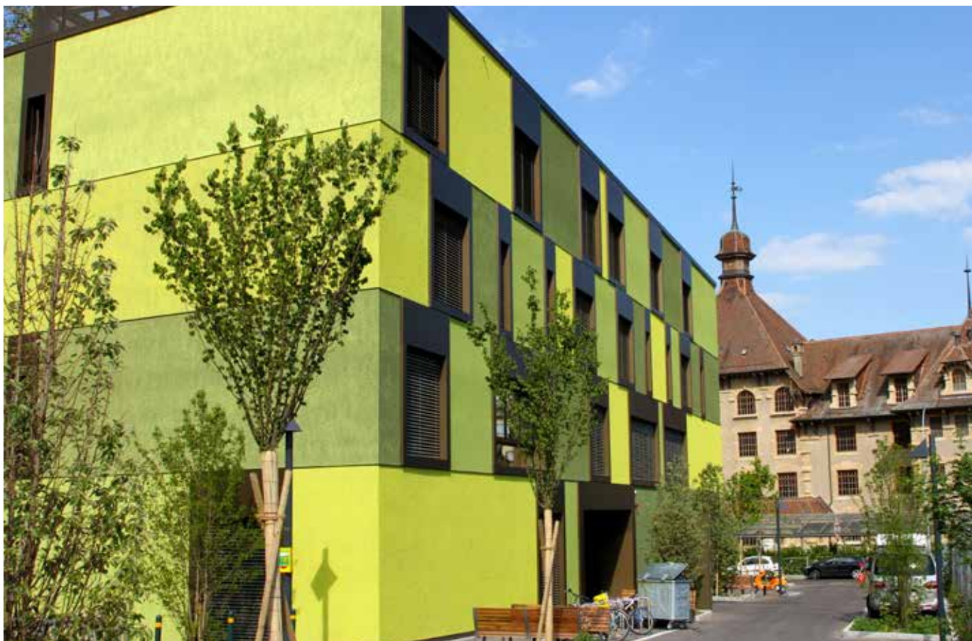
École Foyer Sécheron, Genève ; groupe de travail d'architectes a'akik : bfik architectes, Fribourg avec Küng et associés, Lausanne
