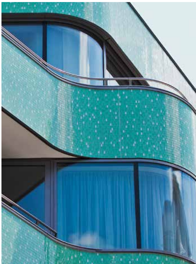
Détail des bandes de façade courbes et recouvertes de mosaïque de verre
