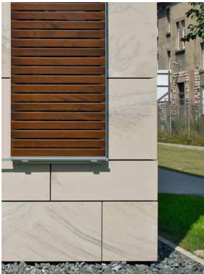
Formation des angles de la façade en pierre naturelle avec joints apparents
