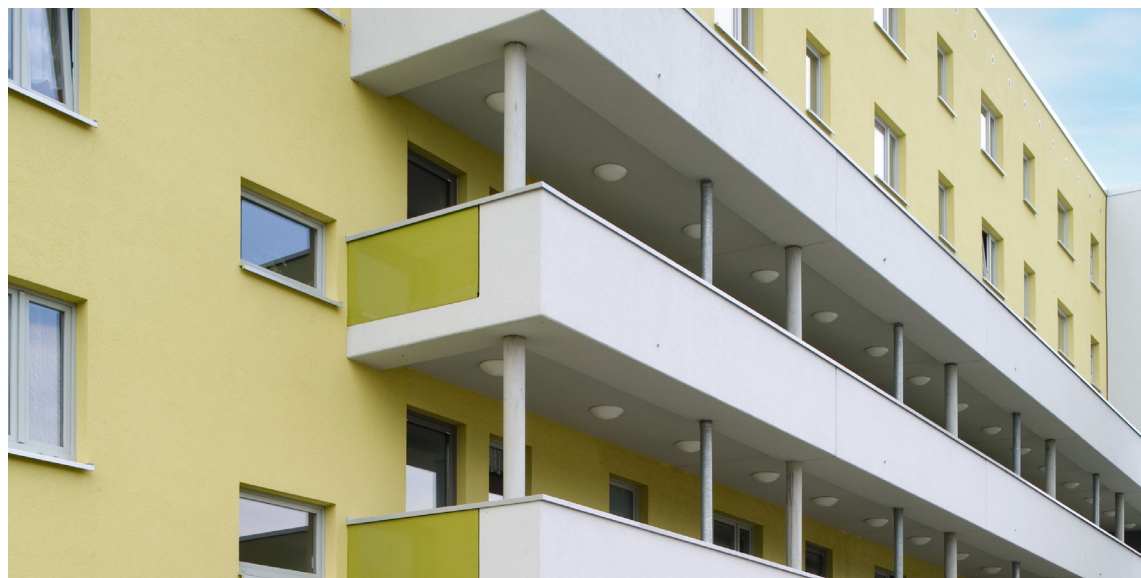
Immeuble collectif, Greifswald, DE Compétences StoCretec : StoFloor Balcony Elastic EB 200 Photo : Maximilian Meisse, Berlin
