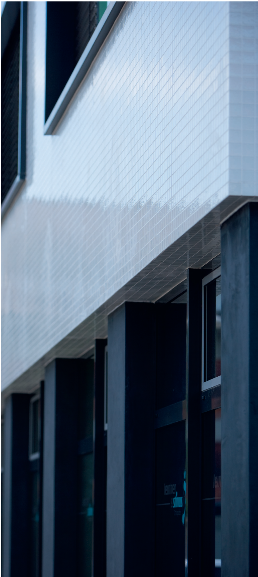
Centre de santé, Oberkirch, DE Maître d'ouvrage : Hurrle Beteiligungs GmbH & Co. KG, Oberkirch, DE Planification : Müller + Huber Architekten, Oberkirch, DE Mise en œuvre : eble ausbau + fassade gmbh, Hohberg, DE Compétences Sto : StoTherm Vario ; StoGlass Mosaic Photo : Johannes Vogt, Mannheim, DE
