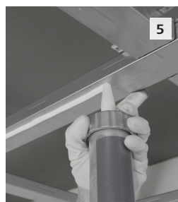
Figure 8 : Buse avec découpe en V
