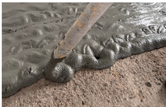
StoCrete TG 302 peut être pompé et convient donc particulièrement aux grandes surfaces de sols industriels.
