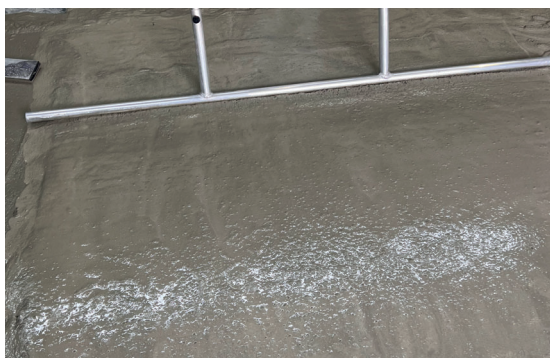
StoCrete TG 302 peut être nivelé et compacté en position debout à l'aide d'une barre de répartition ou d'un dispositif de compactage vibrant, ce qui permet de ménager les genoux et le dos.
