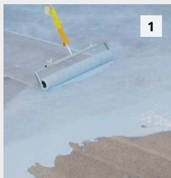
1 Appliquer au rouleau la couche d'imprégnation StoCryl EH 100.
