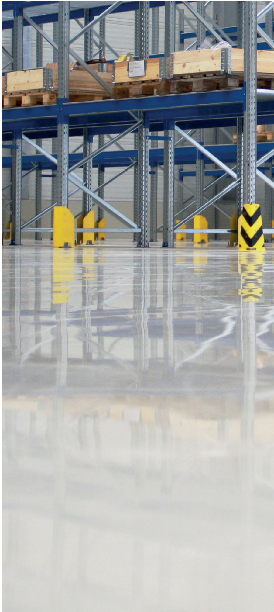
Centre logistique, Olin, Baltringen, DE Système : StoFloor Industry Elastic WHG Deck 100 Photo : Olin, Baltringen
