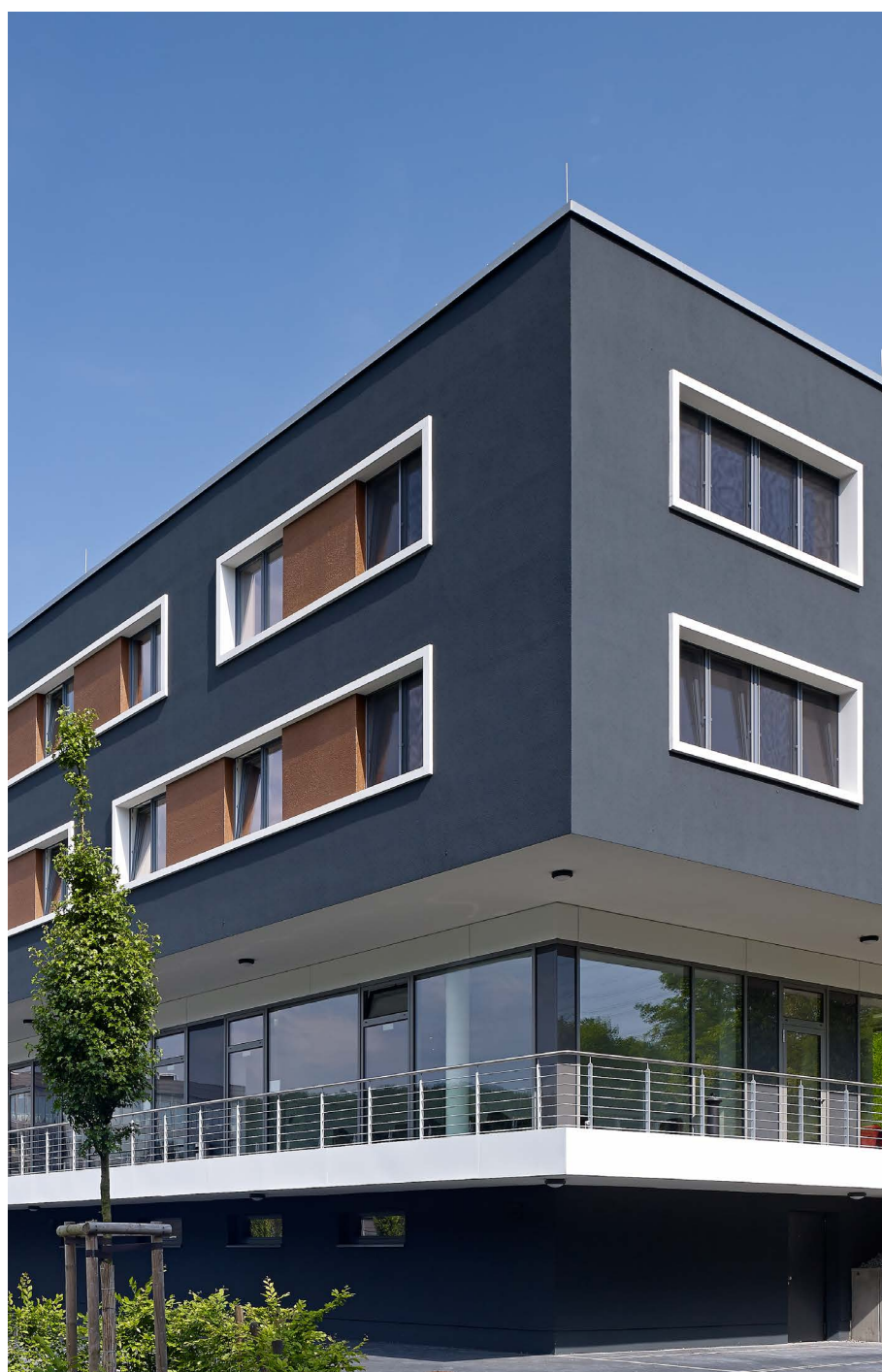
Immeuble Kraftwerkschule, Essen, DE Maître d'ouvrage : Kraftwerkschule e.V., Essen, DE Planification : bgs architekten GbR, Düsseldorf, DE Mise en œuvre : Lurvink GmbH, Bocholt, DE Compétences Sto : StoTherm Classic®, StoColor X-black Photo : Guido Erbring, Cologne, DE
