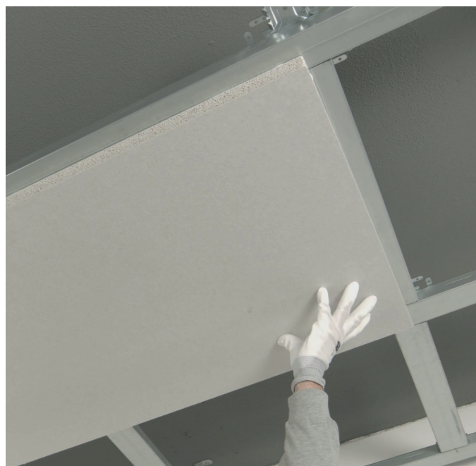
Mise en place de la plaque acoustique
