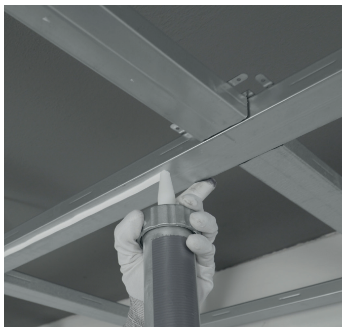
Application de la colle à l'aide d'un pistolet à colle
