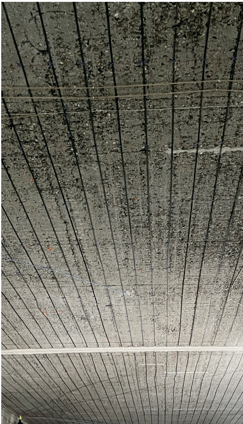
Tunnel Schindellegi, Schindellegi, CH Mise en oeuvre : Strabag SE et Trauffer Bautenschutz AG Compétences Sto : réfection avec enrobage à protection anticorrosion cathodique, StoCrete TS 203, StoCrete TF 300 et StoPox TU 100.
