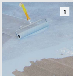
1 Applicazione a rullo sulla mano di ancoraggio StoCryl EH 100
