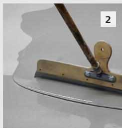
2 StoCrete EH 200 wird mit der Rakel aufgebracht...
