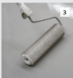
3 ... und mittels Stachelwalze entlüftet.
