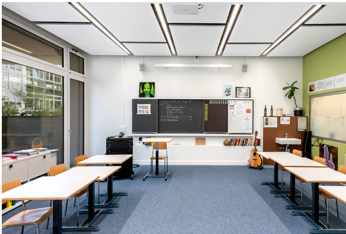
Bild links: Berufsbildungszentrum IDM in Spiez, CH Die Akustik in der Schulungseinrichtung in Spiez wurde mittels StoSilent Modular Deckensegel optimiert.
