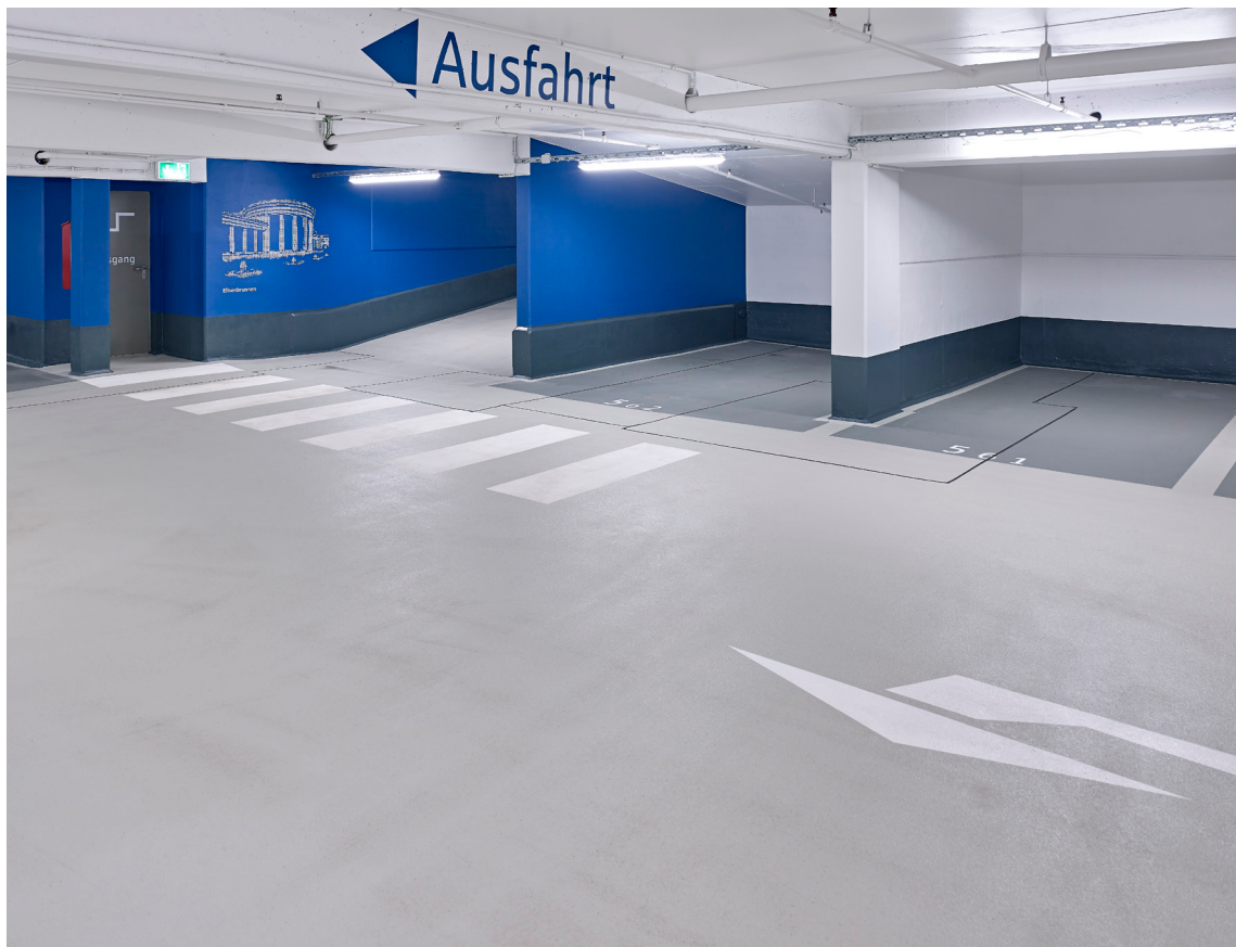
Tiefgarage Sparkasse, Aachen, DE Sto-Kompetenzen: Oberflächenschutz- systeme Foto: Guido Erbring
