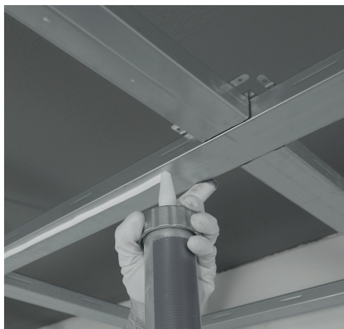
Kleberauftrag mit der Klebepistole
