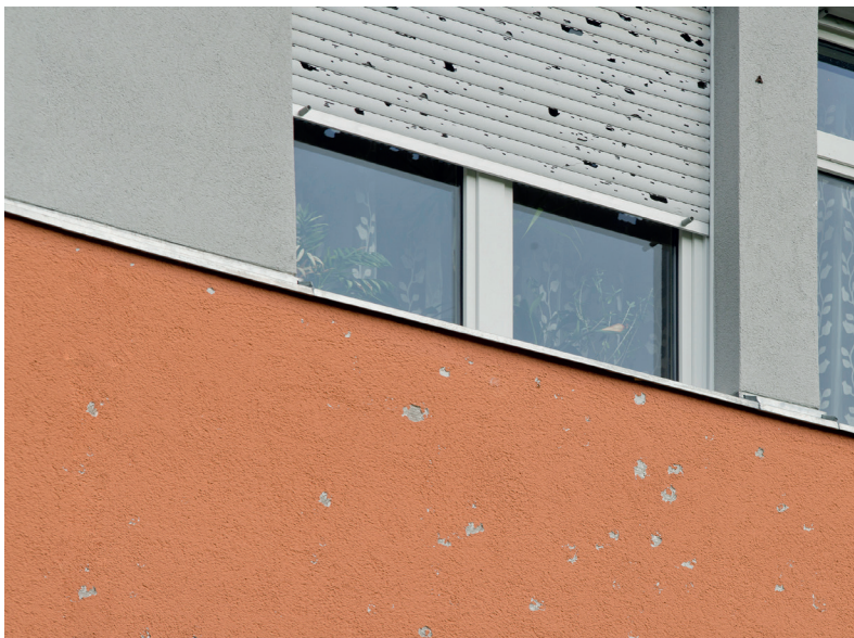
Bild oben: Wo die Hagelkörner auftrafen, hinterliessen sie sichtbare Schäden an der Fassade. Jetzt ist eine gezielte Sanierung erforderlich, um den Schutz und Erscheinungsbild der Fassade wiederherzustellen.
