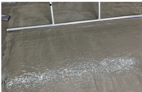
StoCrete TG 302 lässt sich mit Schwabbelstange oder Rüttelbohle knie- und rückschonend im Stehen nivellieren und verdichten.
