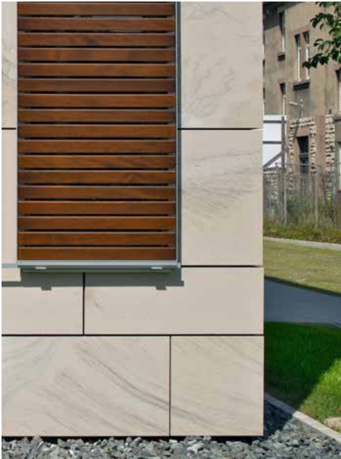
Eckausbildung der fugenbetonten Natursteinfassade
