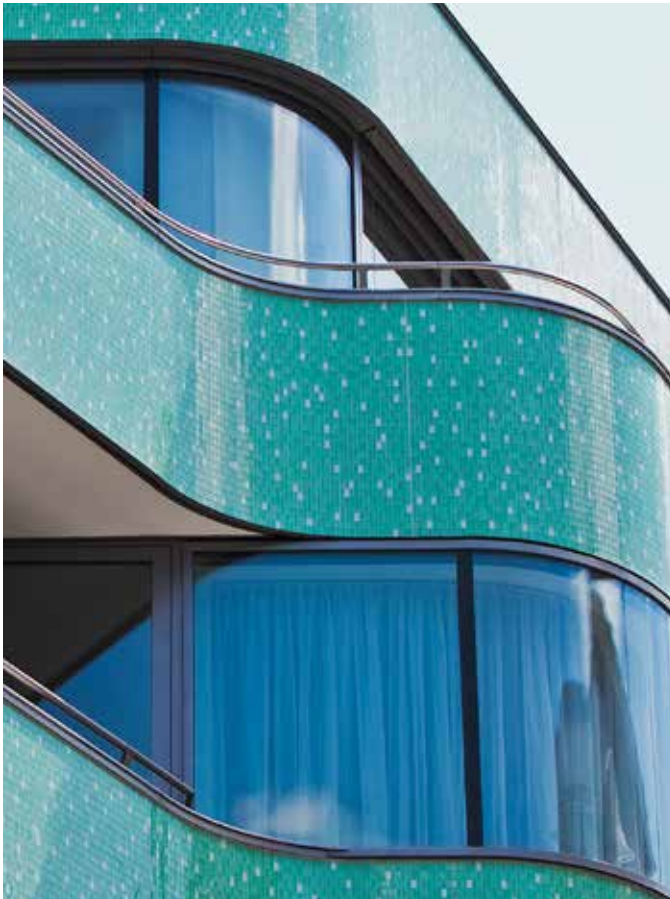
Detail der gebogenen und mit Glasmosaik bekleideten Fassadenbänder
