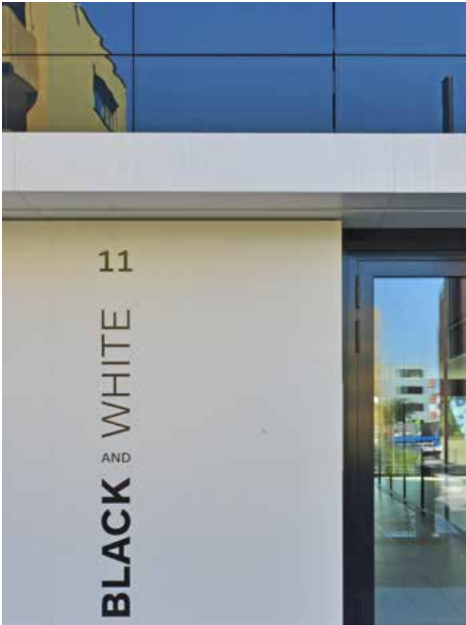
Übergang der nicht sichtbar befestigten Photovoltaik-Paneele zur Fassade
