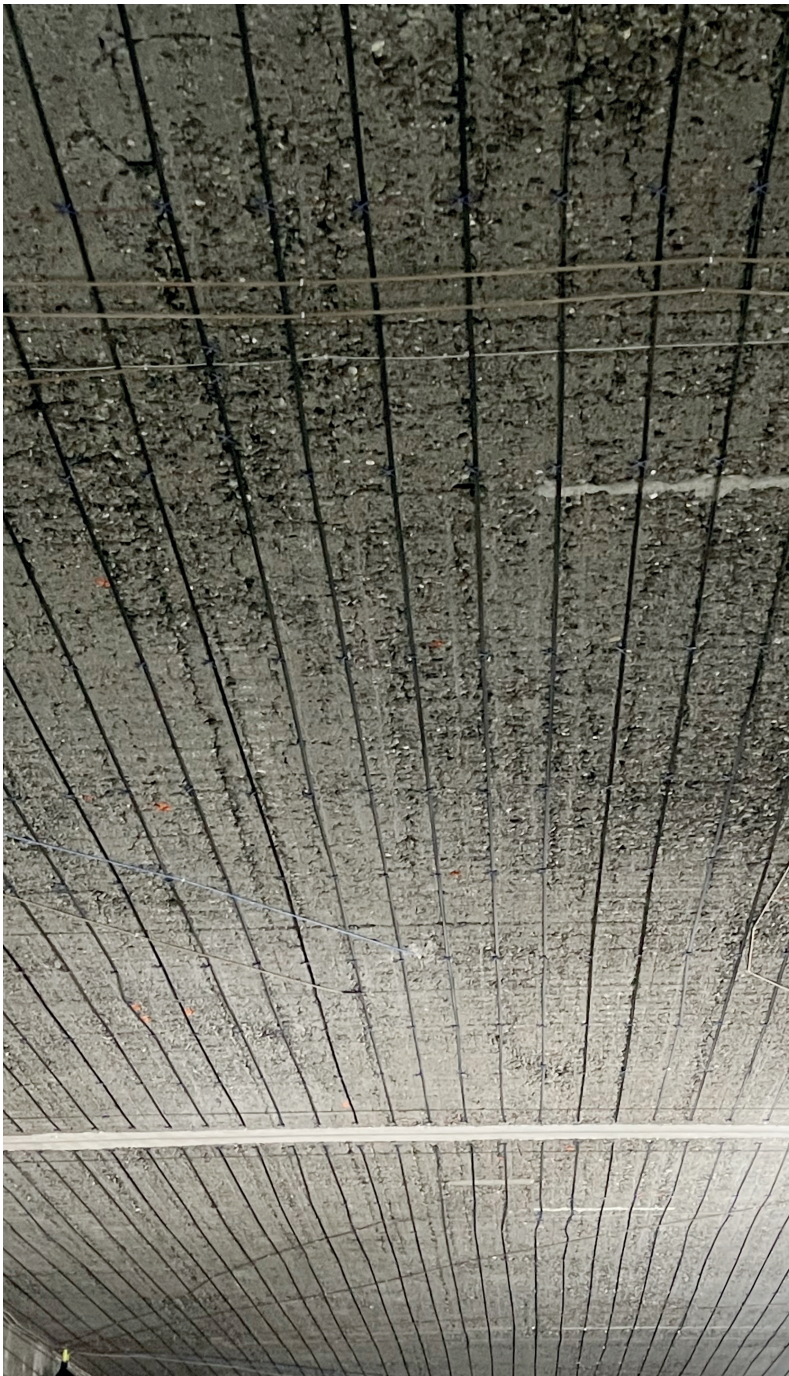
Tunnel Schindellegi, Schindellegi, CH Ausführung: Strabag SE und Trauffer Bautenschutz AG Sto-Kompetenzen: Sanierung mit KKS-Einbettung, StoCrete TS 203, StoCrete TF 300 und StoPox TU 100.
