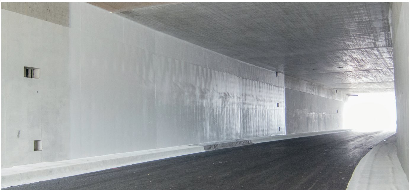
A5/N5 Umfahrung Biel Westast, Tunnel Weidteile, Röhre Bern Ost, CH Richtungstrennte Tunnelröhre mit zwei Fahrspuren, erstellt im Tagebau.
