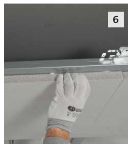
Abbildung 10: Richtige Verklebung der Akustikplatten
