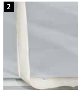
2 Klebebänder sofort entfernen
