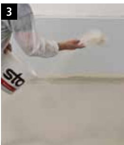
3 StoQuarz 0,3-0,8 mm in leichtem Überschuss, ca. 3 kg/m 2 , in die frische Beschichtung StoPma DL 300 farbig einstreuen.
