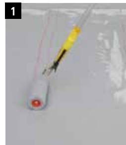
1 Gewebe mit StoPma EZ 300 einlaminiert
