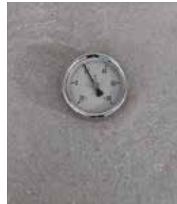
Untergrund geschliffen mit Thermometer
