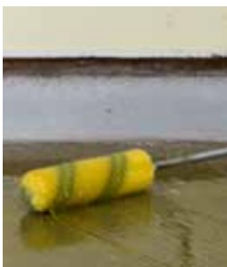
Zur Aushärtung der Grundierung ist ein geschlossener Harzfilm erforderlich
