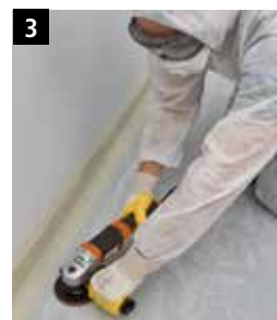
3 StoPma EZ 300 kann nach 60 Minuten überarbeitet werden.
