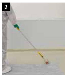
2 StoPma DL 300 farbig mit der Rolle verteilen. Nicht nachstacheln!
