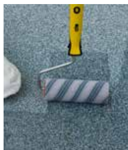
Versiegelung mit StoPma DL 300 transparent
