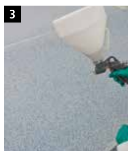
3 Einblasen der StoChips 1 mm mit der Trichterpistole
