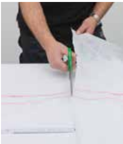
Gewebeeinlage zuschneiden
