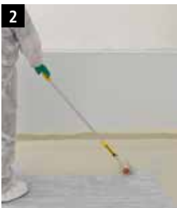
2 StoPma DL 300 farbig mit der Rolle verteilen.
