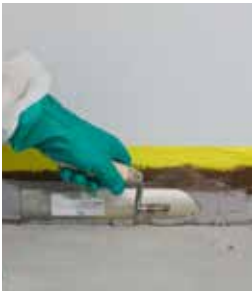
Hohlkehle mit StoJet IHS mit StoQuarzmischung M1.2
