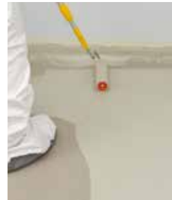
Kopfversiegelung mit StoPma DL 300 farbig
