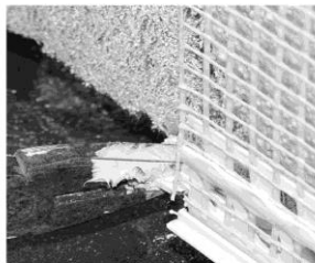
Justieren des Fugenflankenprofil- Verbinders
