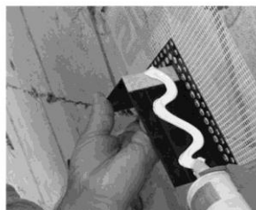
StoColl Fix auftragen
