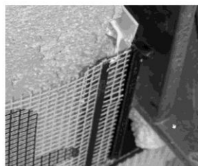
Eingebautes Eckstück mit Fugenflankenprofil-Verbinder
