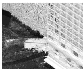
Justieren des Fugenflankenprofil- Verbinders
