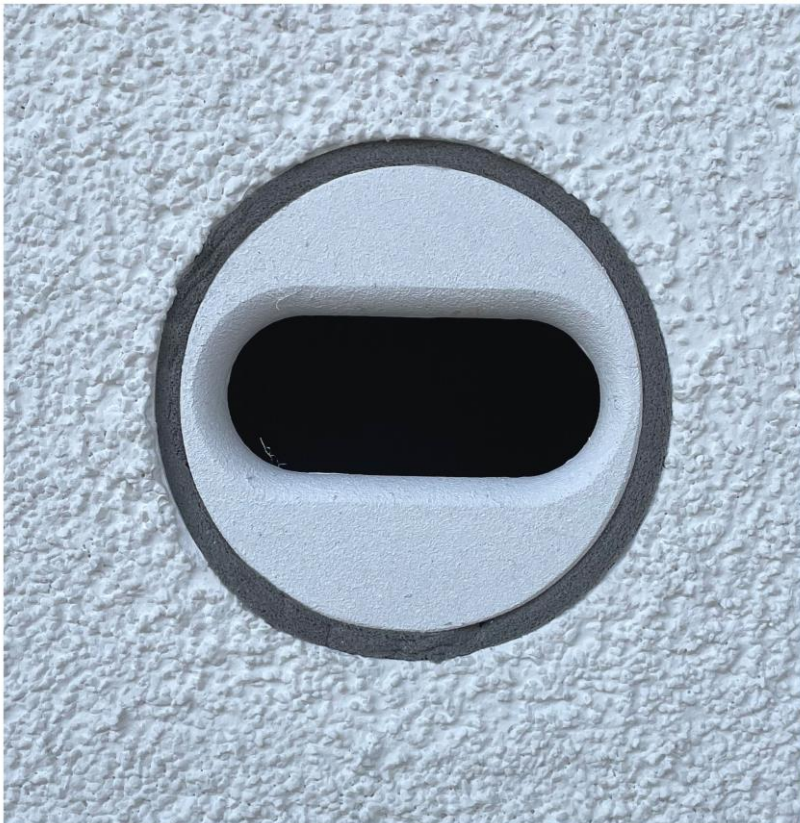
illustration : StoElement Fauna MS-I 11 rosette avec compribande en périphérie (StoReno Bande comprimée 10/4)
