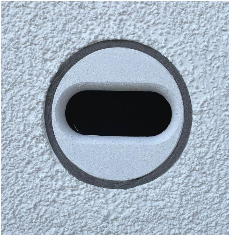
figura: StoElement Fauna MS-I 11 Rosetta con nastro sigillante perimetrale (StoReno Fugendichtband 10/4)
