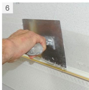
Mise en œuvre
