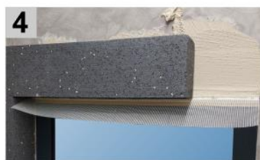
fasi di lavoro 1 – 4
